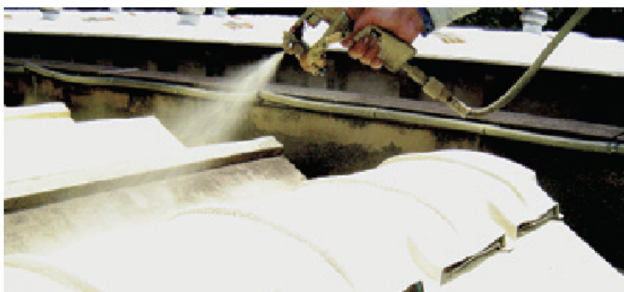
Aplicação do Spray de Poliuretano no telhado da empresa Isla
